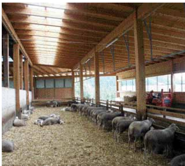
Heller Stallzubau durch zusätzliche Lichtöffnungen in der Dachfläche
