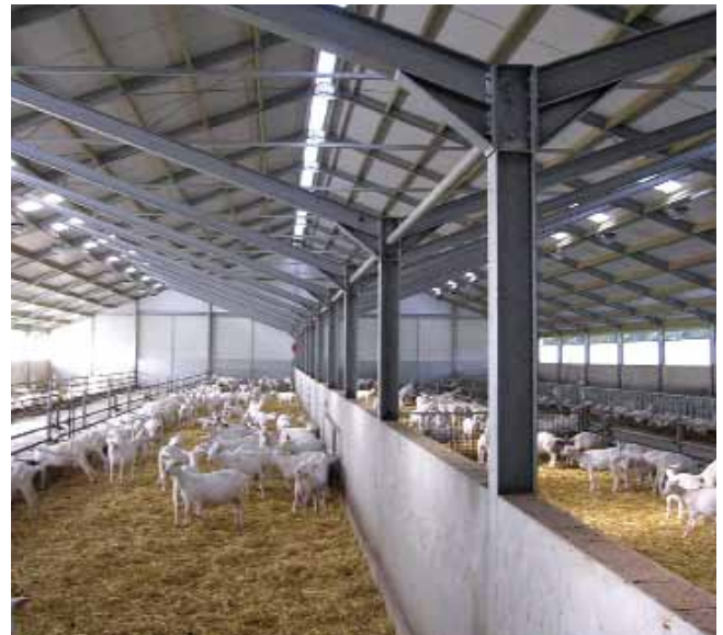
Halle mit Querlüftung
